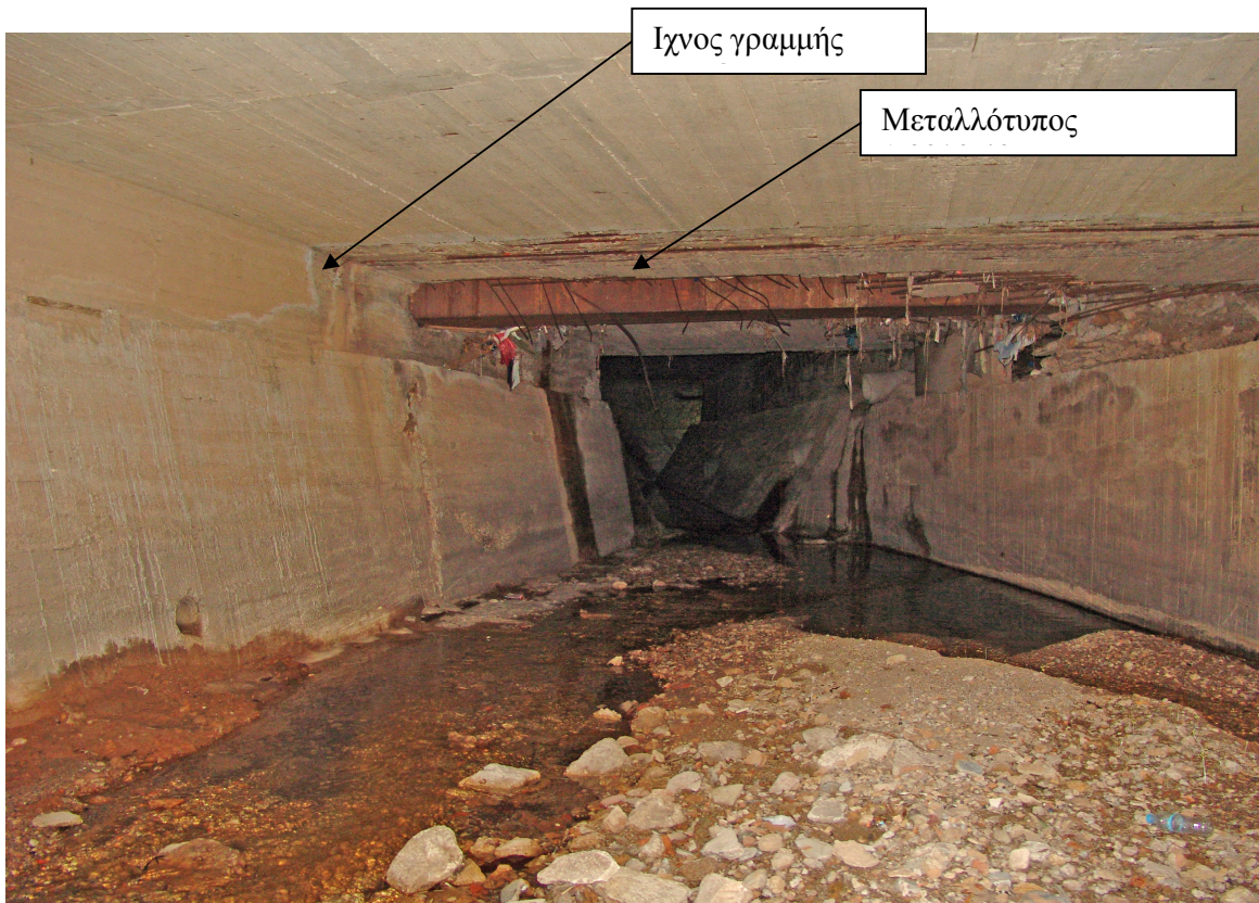
ΦΩΤΟ-1 Φωτογραφία του υφιστάμενου οχετού με την εγκάρσια τομή της πλάκας οροφής
